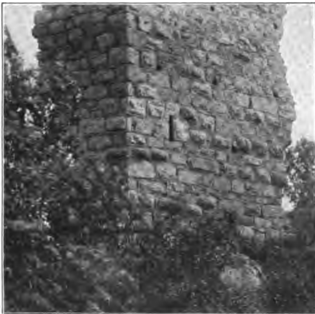
Fig. 127. Siegenstein. Mauerwerk der Burgruine (Detail von Fig. 128).
